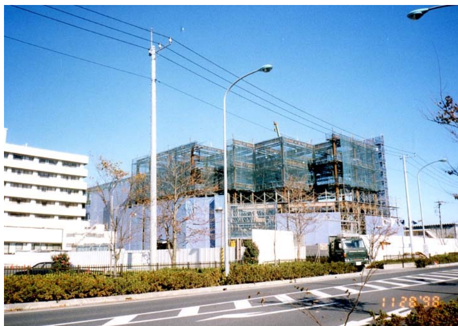
東館建築風景（平成 10 年 11 月）
